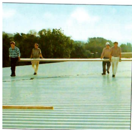
Montaje de un tejado ligero
