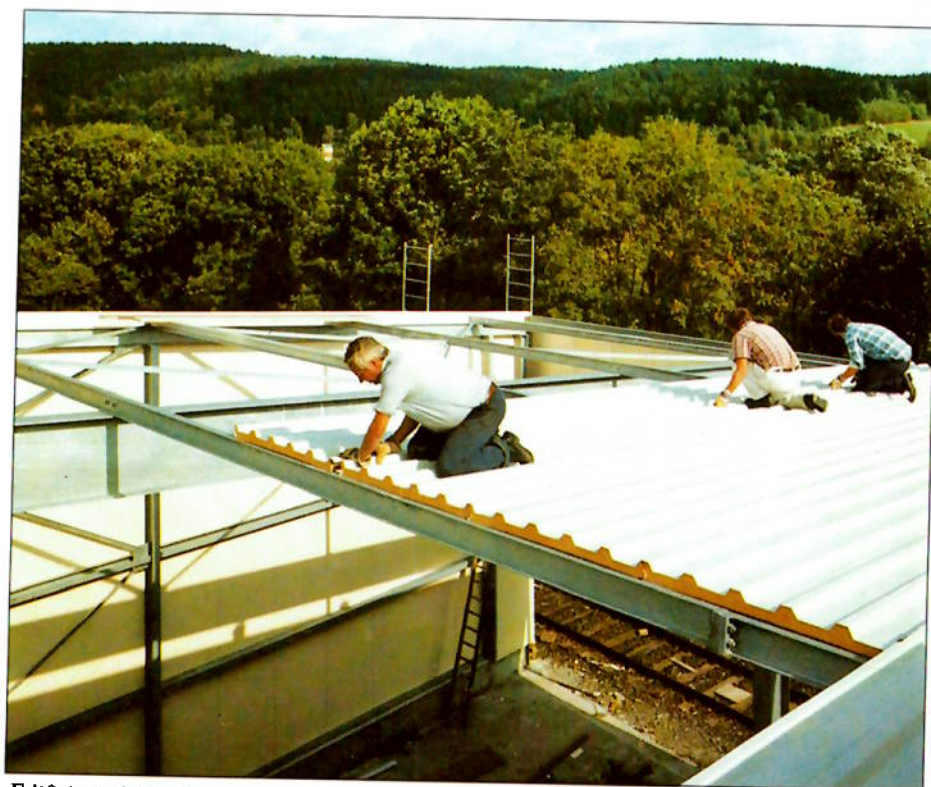
Edificio industrial con tejado ligero prefabricado
